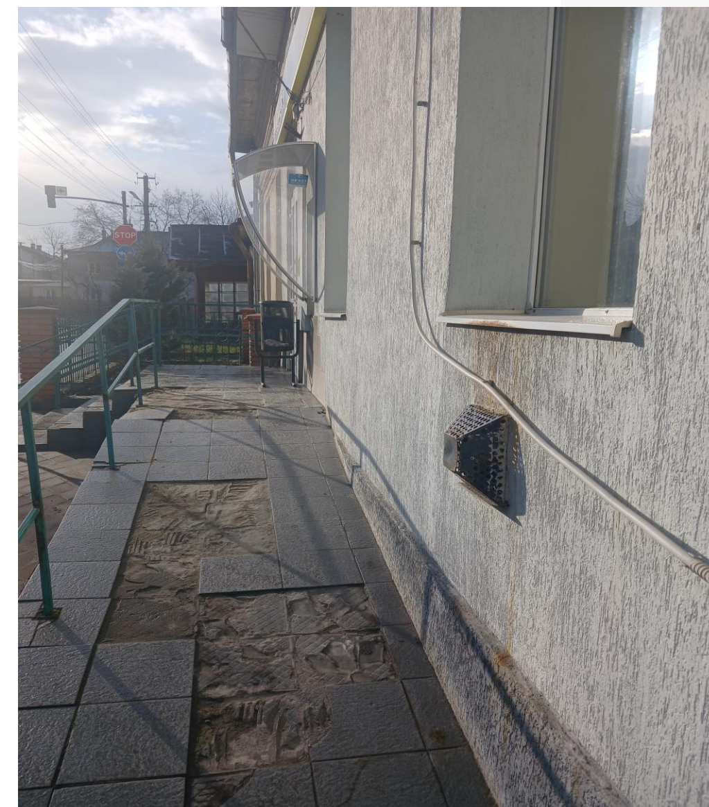
ОЩАДБАНК (Частково безбар'єрний об'єкт) 1. Реконструкція пандуса 2. Покращення сходинок
